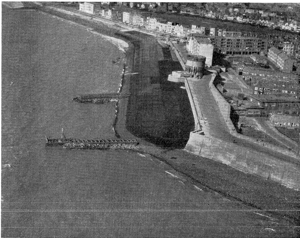
De „Boulevard de Ruyter” te Vlissingen na het aanbrengen van de verzwarening voor het westelijke gedeelte van de zeemuur. Rechtsonder een gedeelte van de oude zeewering zonder buitenberm 3-10-'58
