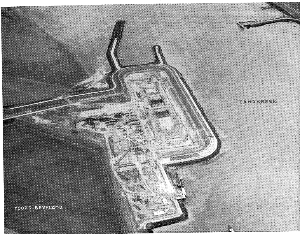
De sluisbouw in de Zandkreek op 29 december 1958
