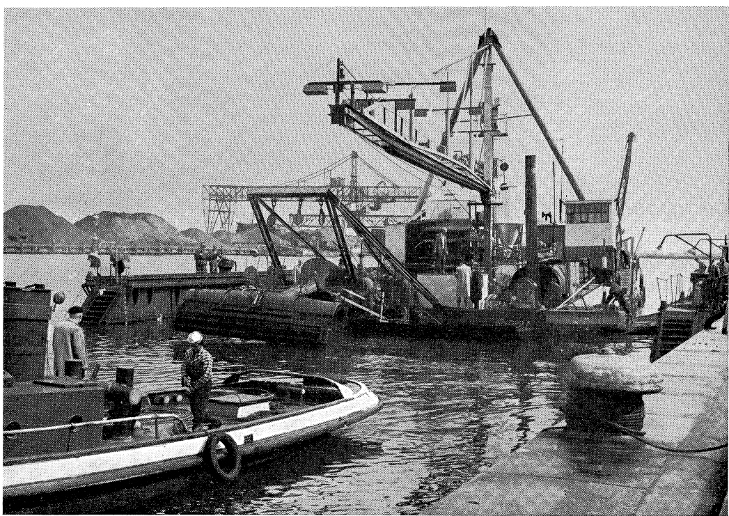
De „Dorus Heijmans” met het stortsteenapparaat in het dok
