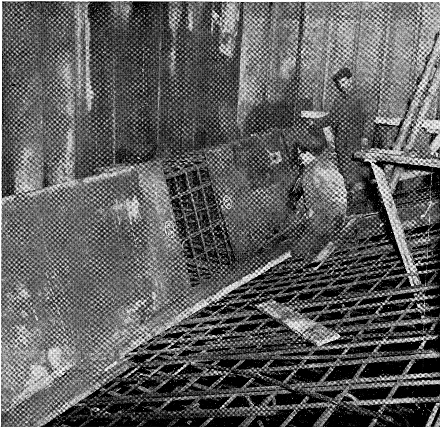
De betonnen drempel waarop de schuif komt te rusten in aanbouw
