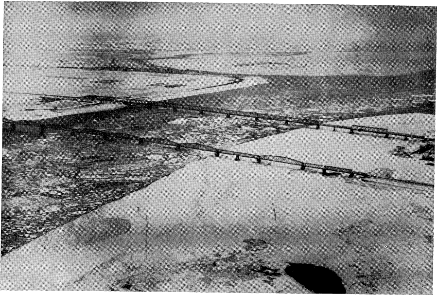
Ijsafvoer bij de Moerdijkbruggen
