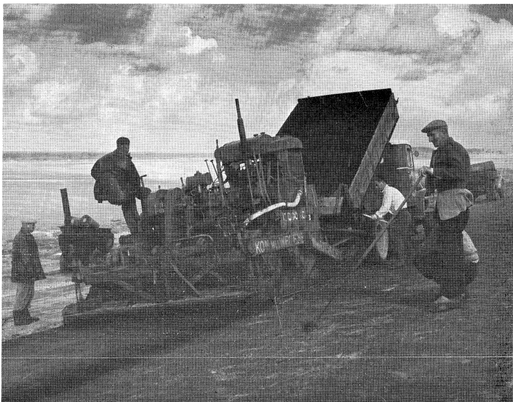
Het aanbrengen van de bovenlaag van asfaltbeton
