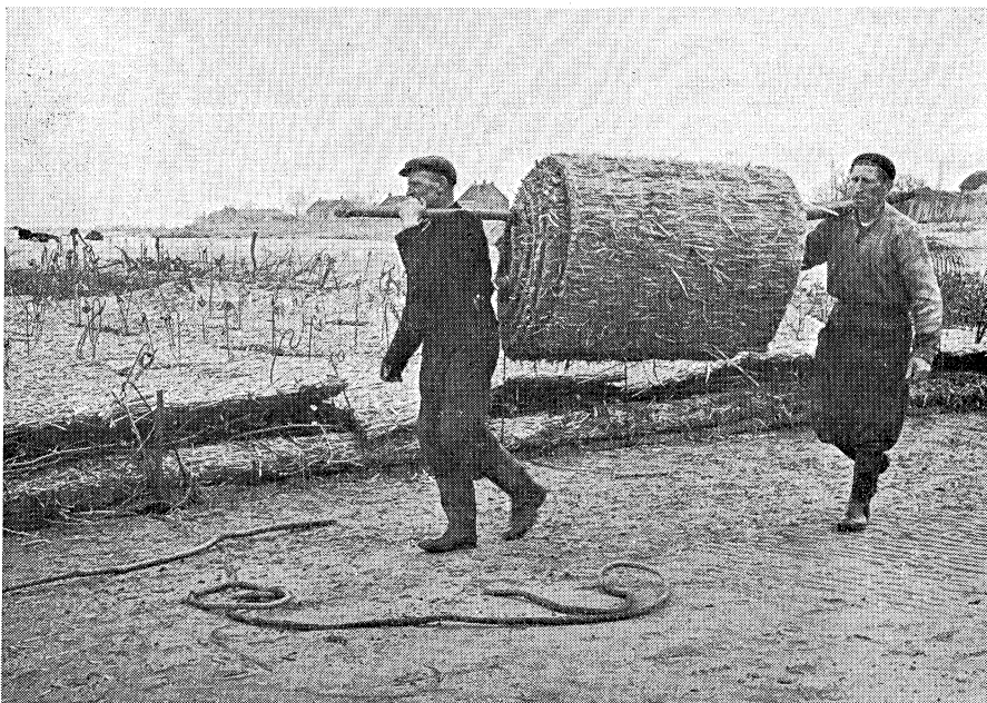
3. Aanvoer van de geperste rietmatten
