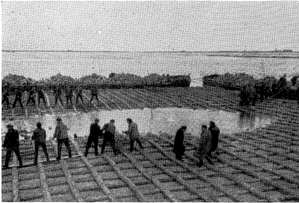
Een rietplaten zinkstuk tijdens het ballasten
