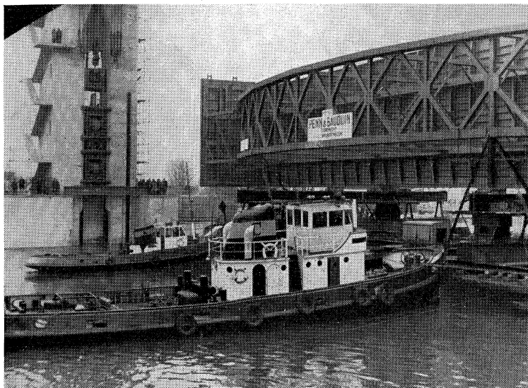
De schuif wordt ingevaren
