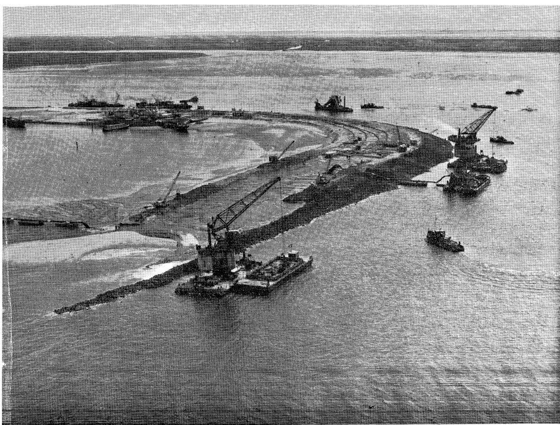
De in aanbouw zijnde ringdijk rond de bouwput in het Haringvliet bewesten Hellevoetsluis. Stand van het werk op 20 mei 1957
