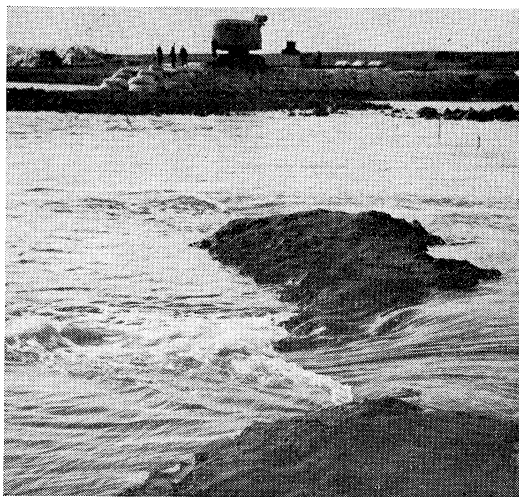
Met asfalt gestabiliseerd zand, gestort met behulp van een grijper. Stroomsnelheid 2,8 m/sec.
