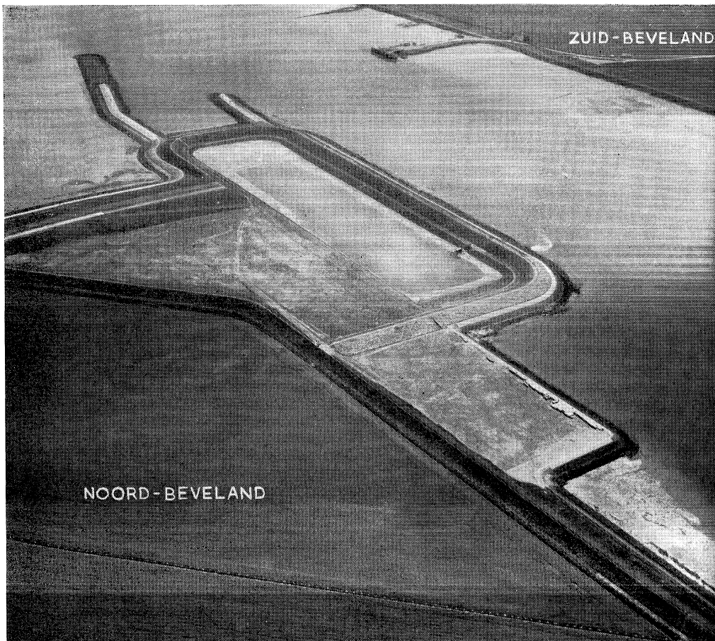
De bouwput voor de sluis
