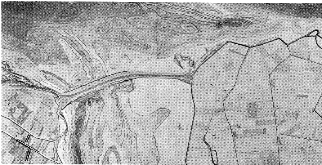
De voltooide dam
