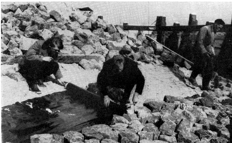
Het aanbrengen van de plastic folie
