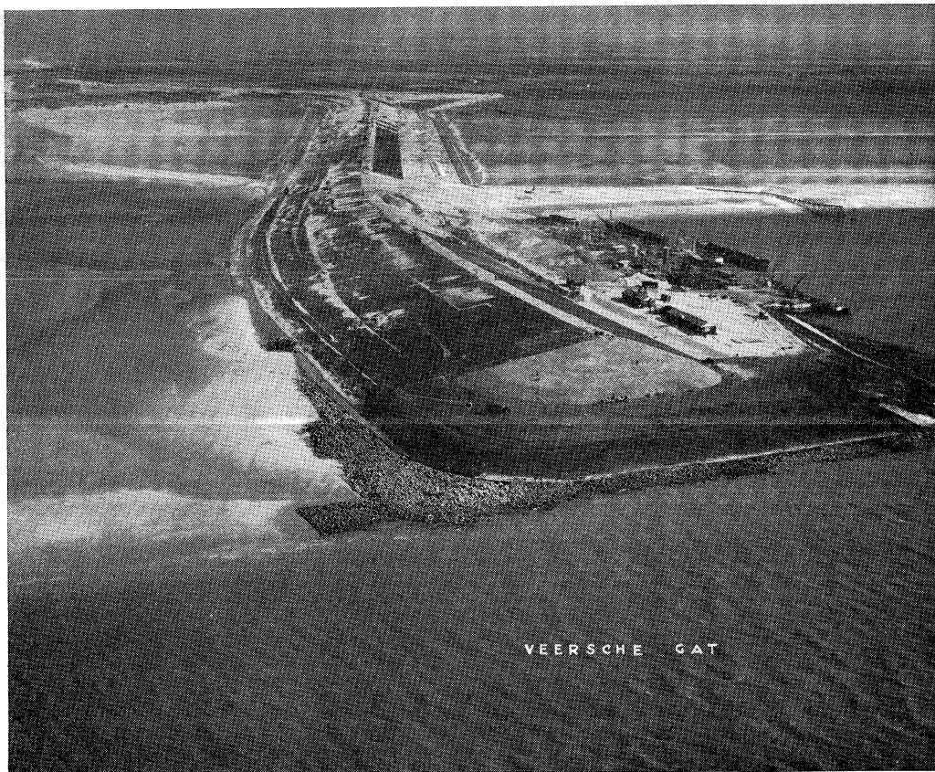
Overzicht van het werk op 3 oktober 1958. De oppervlaktebehandeling met gebroken grind is op de kop zichtbaar.
