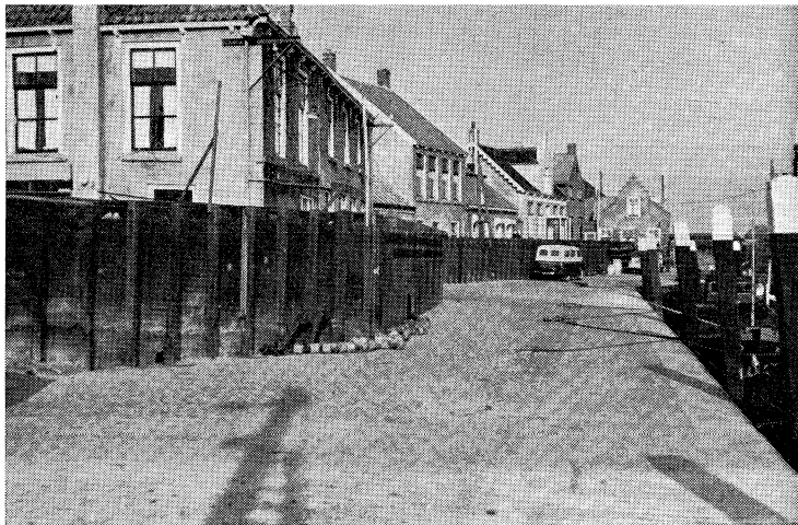
Kistdam ter versterking van de hoogwaterkering in Bruinisse
