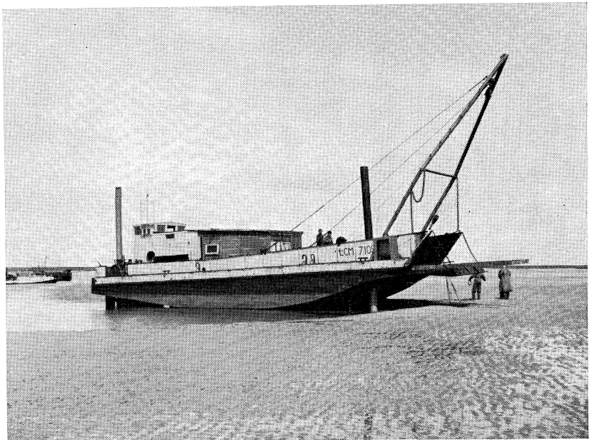
Landingsvaartuig ingericht voor het boren
