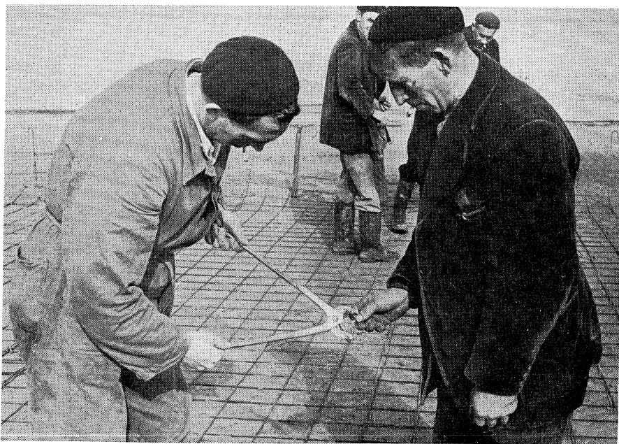
2. Aanbrengen van de schalmen
